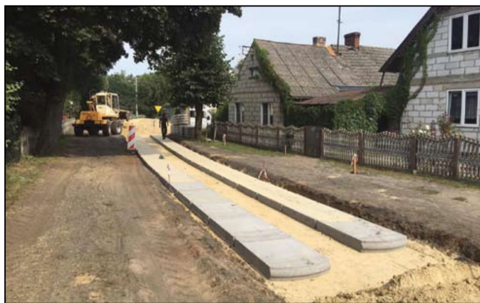
Budowa drogi w Mariankowie
