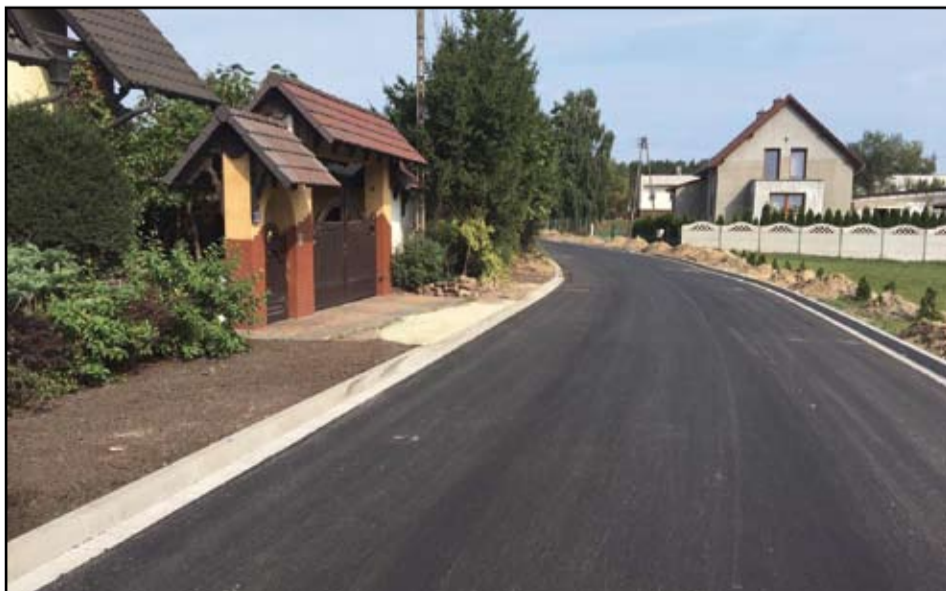
Wyremontowana droga w Kopanicy
