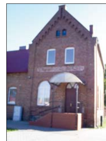
Budynek w Karnie
