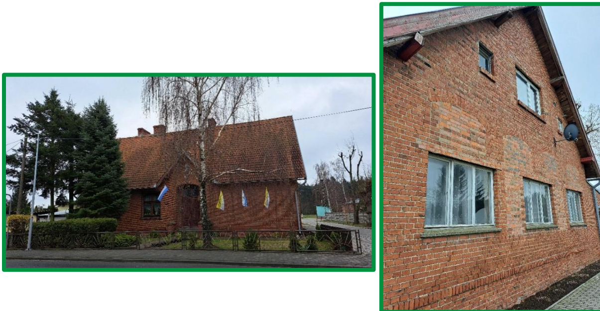
Ryc. 22. Budynek mieszkalny komunalny - Żodyń ul. Główna 43
