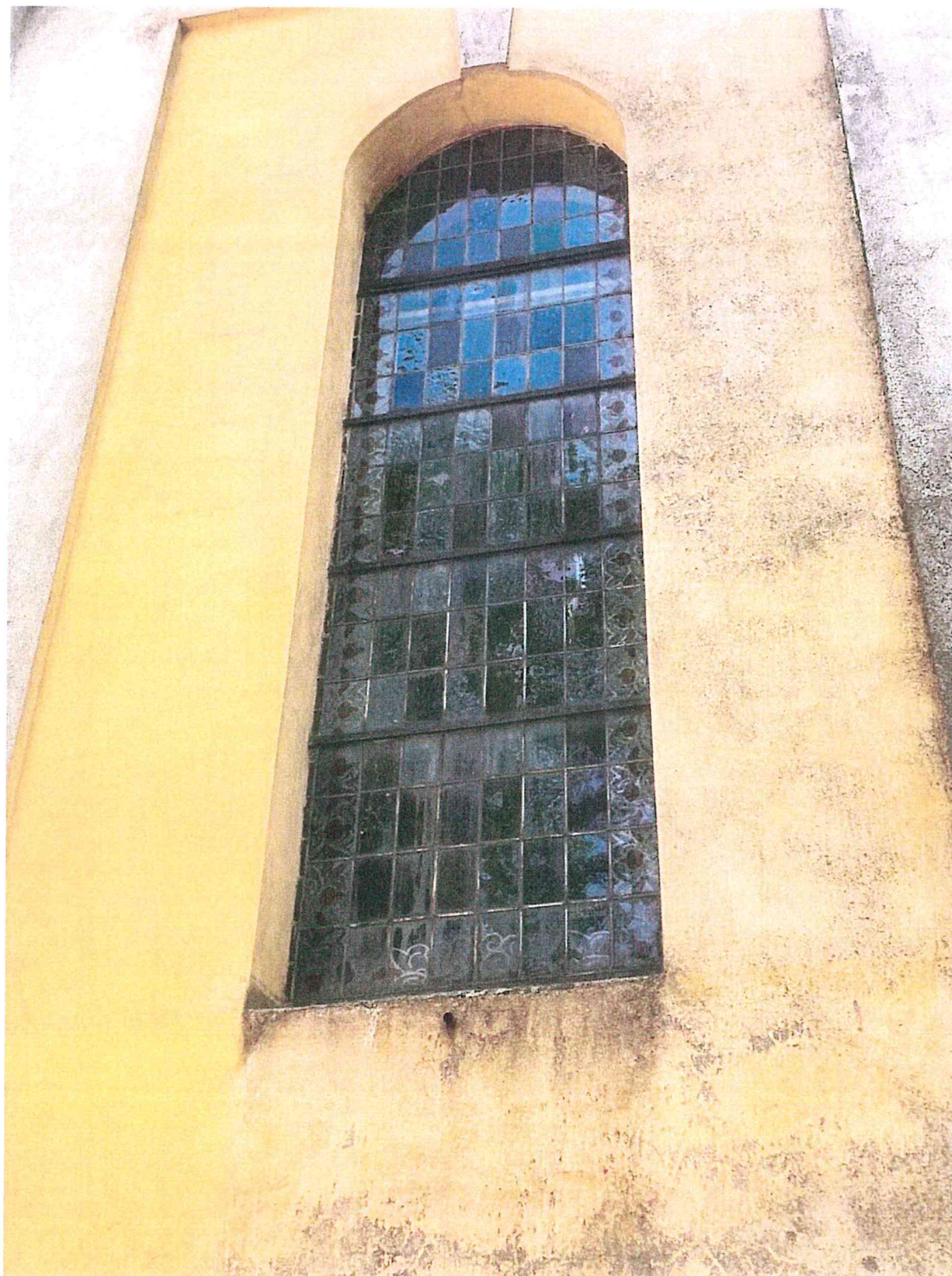
Fot.2. Witraż z okna sIII przed konserwacją i restauracją. Widoczny brak przeszklenia zabezpieczającego oraz liczne zacieki, zabrudzenia szkła i korodujące elementy metalowe
