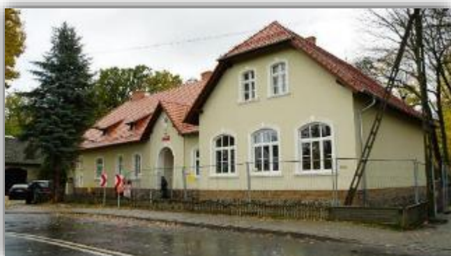
Wyremontowany budynek szkoły podstawowej w Tuchorzy
