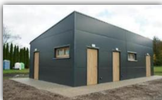
Szatnia kontenerowa w Tuchorzy
