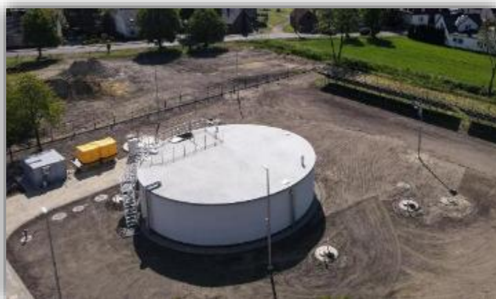
Tłocznia ścieków w Siedlcu
